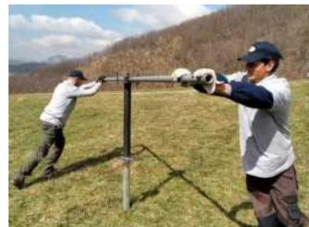
Una volta installate le viti si vanno a fissare i montanti utilizzando la staffa di collegamento e bulloni M10.
