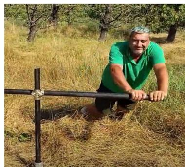
Una volta installate le viti, si inseriscono i tubi che vengono resi solidali alle viti stringendo 6 grani a punta conica M12
