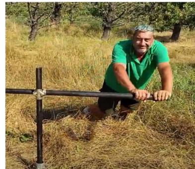
Una volta installate le viti, si inseriscono i tubi che vengono resi solidali alle viti stringendo 6 grani a punta conica M12
