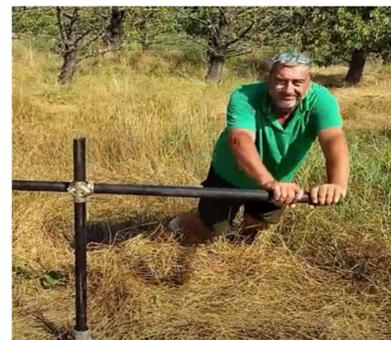
Una volta installate le viti, si inseriscono i tubi che vengono resi solidali alle viti stringendo 6 bulloni M12 x 40
